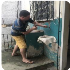
Colocação da pia Infantil.
